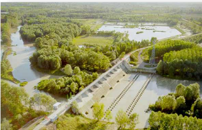
Cassa d'espansione sul fiume Panaro
